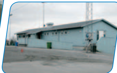
Garderobeanlegget på Nordre Åsen
